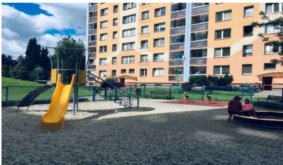
Opravené Dětské hřiště na sídlišti „Sever“
